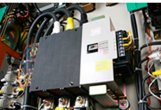
業界での知名度は高い。写真は2系統電源が準備された状態において系統間の切り替えを無瞬断(10 \mu sec以下の断時間)で切り替える装置。
